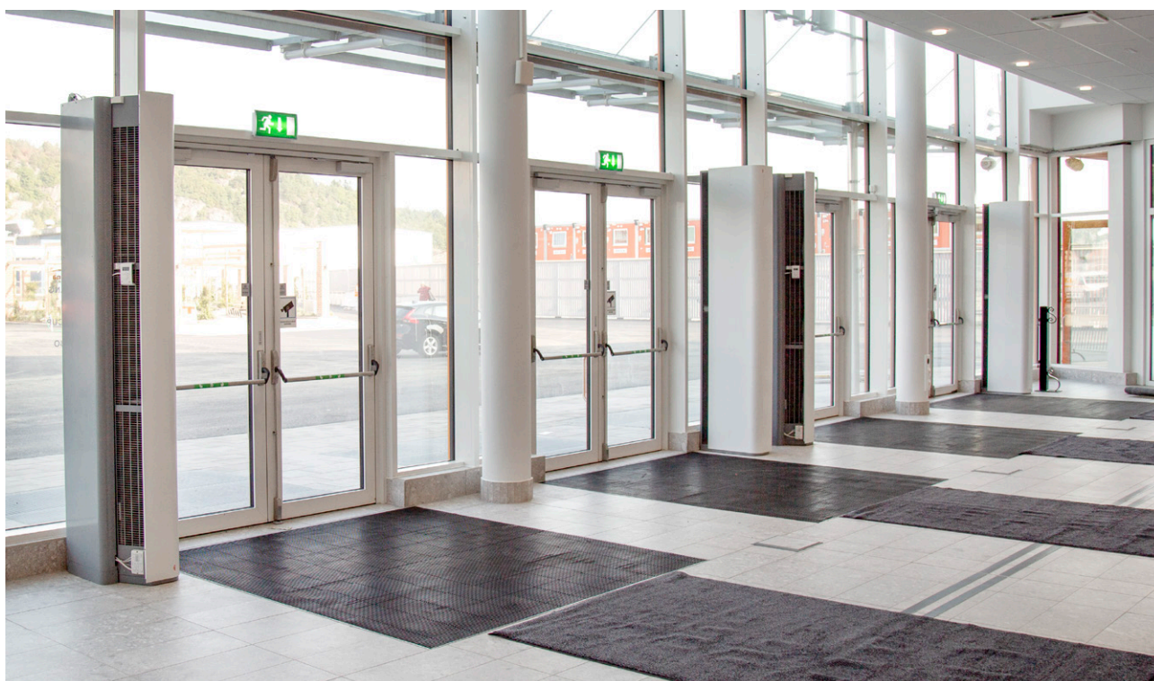
Zamontowane pionowo urządzenia Pamir 3500 z zestawem maskownic do ukrycia rur i przewodów.
